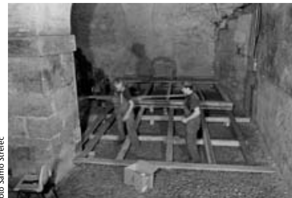
Gradnja tribune v grajski kleti
